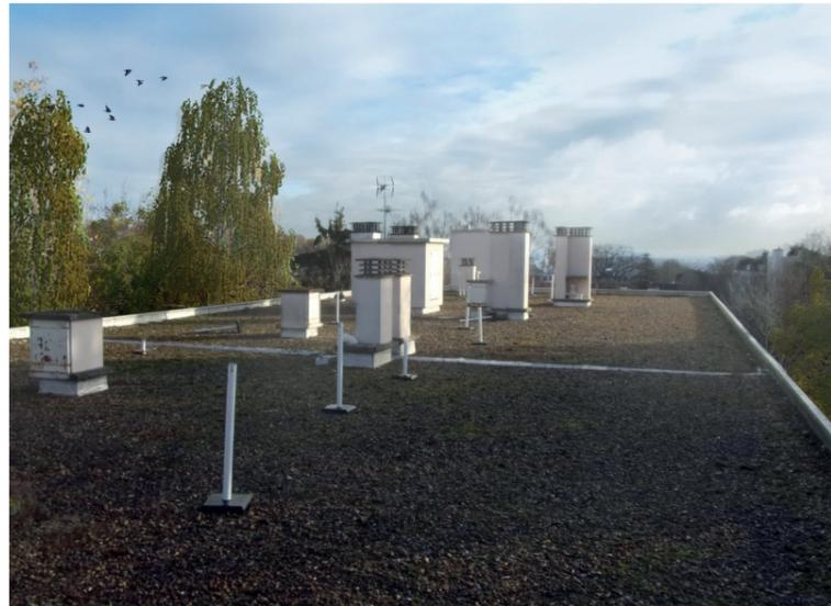
Avant : toit-terrasse avec étanchéité et protection en gravillons
